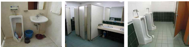
실내화장실 소변기(D) 외부 화장실(G-4) 외부 화장실(G-10)
