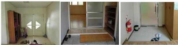
보조기구 보관(A-3) 현관과 내부공간 사이 미닫이문 설치(A-5) 사용불편한 신발장(L-1)
