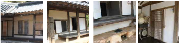
<그림 11> 『중전리고가』 안방 안마당 쪽 창호의 토머름 <그림 12> 『지곡리고가』 안방 뒷마당 쪽 창호의 토머름 <그림 13> 『후산리고가』 건넌방의 안마당 쪽 창호(左)와 대청 쪽 복합 형태의 정자살(右)
