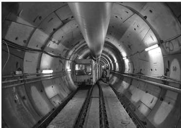
(4) 갱내 캘리포니아 스위치 설치
