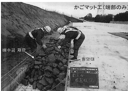
(c) 철망태를 이용한 배수공 재료의 고정
