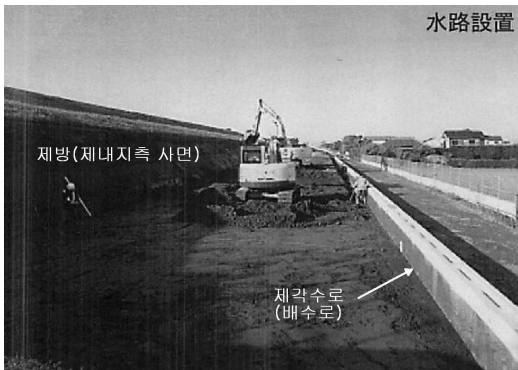
(a) 제내지측 사면의 절개와 제각수로의 설치
