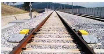
그림 7. 차축 온도 감지장치 설치 예시
