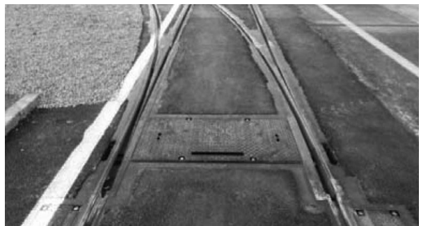
그림 9. 매립형분기기의 설치
