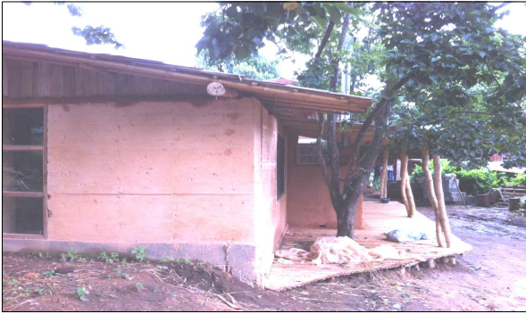
그림 12. 흙벽과 대나무 지붕 시공
