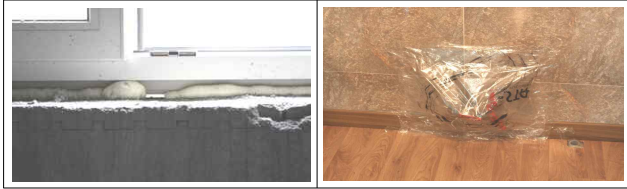
a. 벽-프레임 틈새 b. 설비관로 밀봉 그림 3-4. ALT-2 기밀 시공사진
