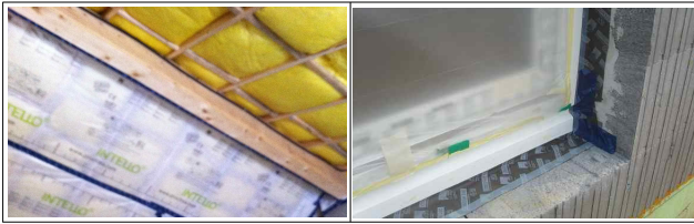
a. 지붕 기밀작업 b. 벽-프레임 그림 3-8. ALT-4 기밀 시공사진
