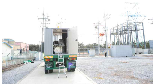
그림 2. 인공고장 발생장치의 외관 사진 Fig. 2. Outside view of the artificial fault generator
