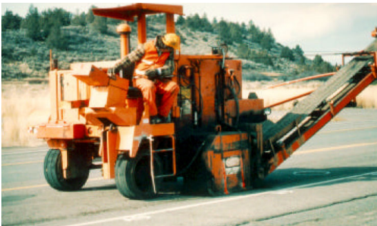
(b) 밀링 장비를 이용한 단부 정리
