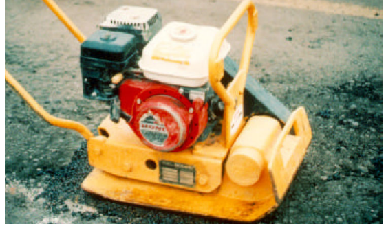
(c) 휴대용 다짐장비를 이용한 다짐 그림 5. 반영구적인 보수공법
