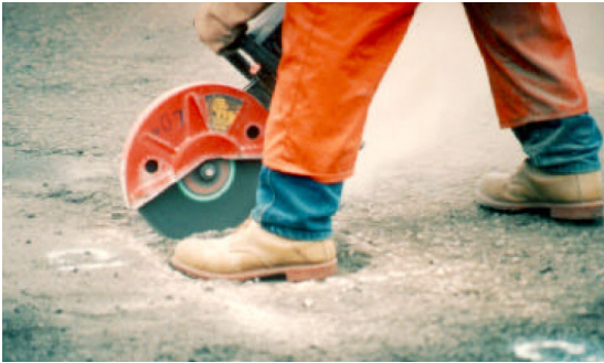
(a) 콘크리트 커터를 이용한 단부 정리
