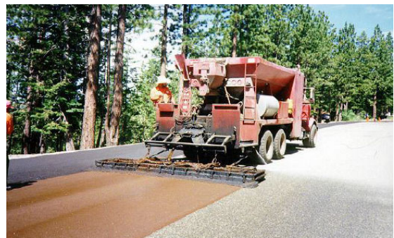
(b) 시공 전경
