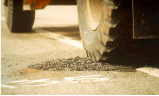
(b) 트럭 하중에 의한 다짐 그림 4. Trow-and-Roll 공법
