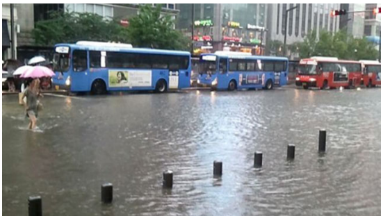
그림 6. 배수불량에 의한 도로 침수
