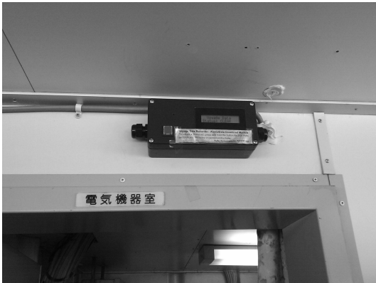
(그림 7) Rutter사 항해자료기록장치 원격제어패널 샘플 사진
