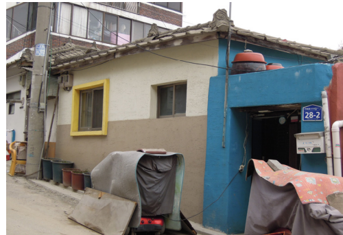
Figure 6 주택에너지효율개선사업 시행가구 (외단열벽체 시공).
