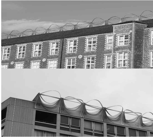
그림 17. 지붕설치형 풍력발전(windwall)
