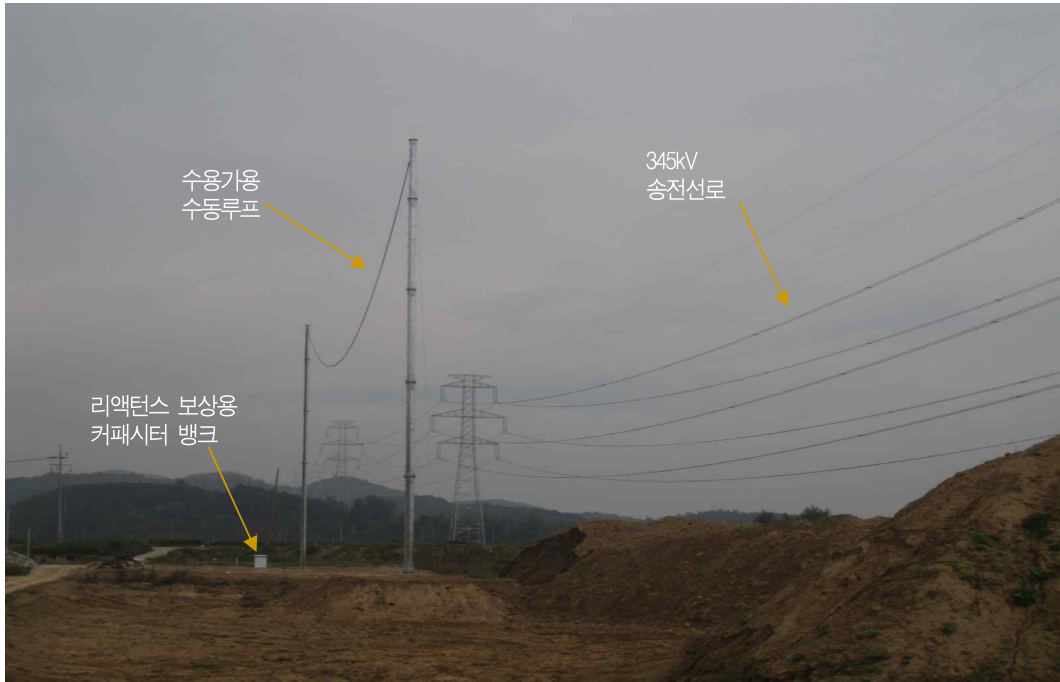
그림 14. 달성 345kV 송전선로 및 수용가용 수동루프 설치 전경
