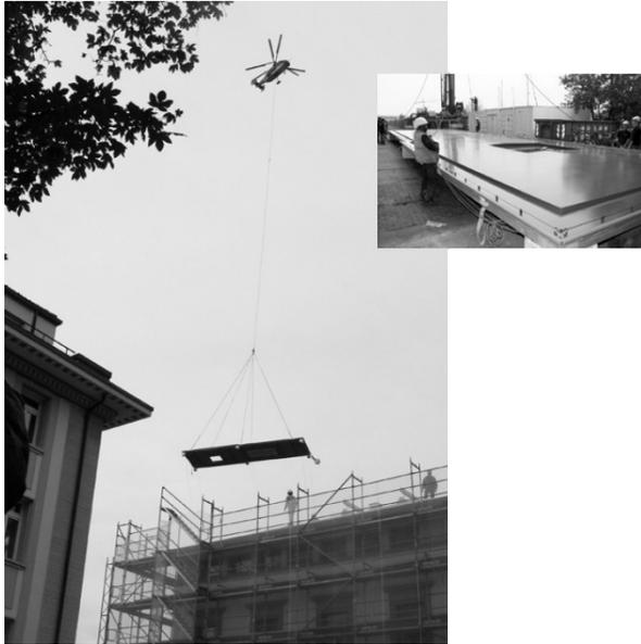
그림 2. 헬기로 목적지로 경량 복합신소재 루프 어셈블리를 공수하는 전경
