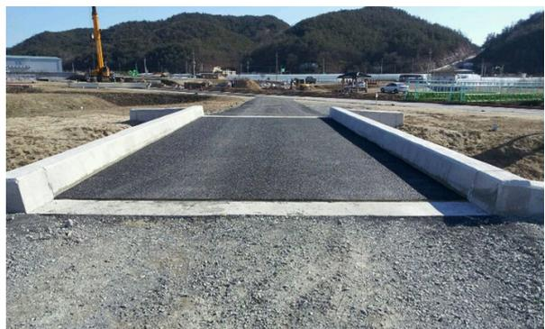
(d) Bridge Deck Pavement using Bio-Polymer Concrete
