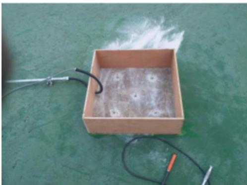
Fig. 7 시설물 지진가속도계측기 받침 설치 전경
