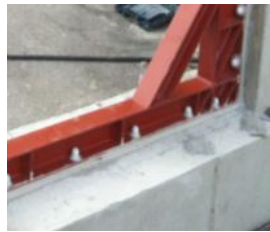
(d) Application of epoxy
