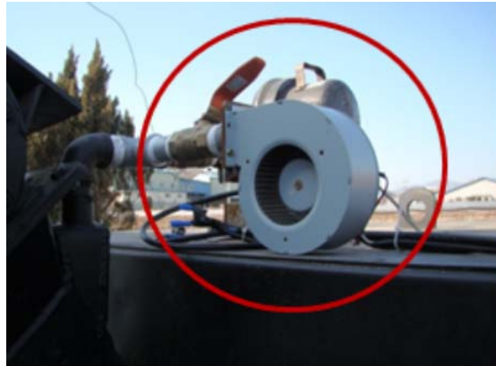
<그림 9> 정전 시 작동하는 DC 역회전에 의한 3차 역회방지
