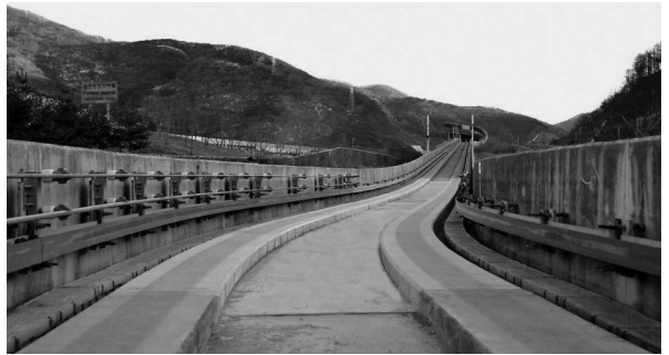
그림 11. 곡선형 프리캐스트 패널의 시험부설 구간(경산시험선)
