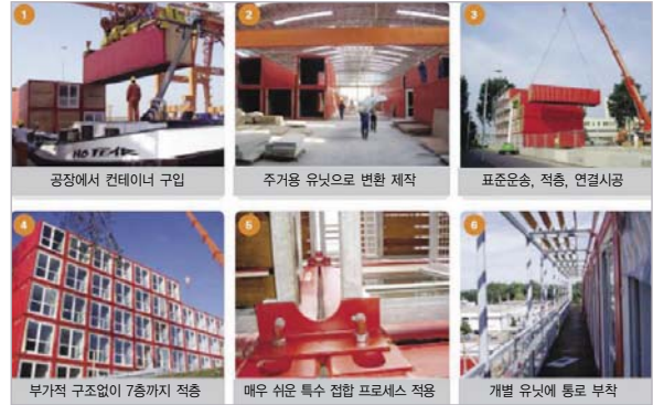
▲ [그림 5] 키트보넨 시공과정 (출처: www.tempohousing.com )
