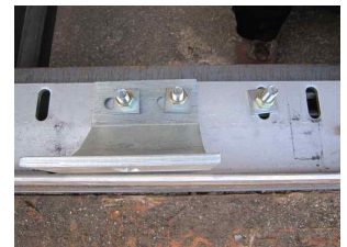
그림 6. 패스닝 유닛 설치
