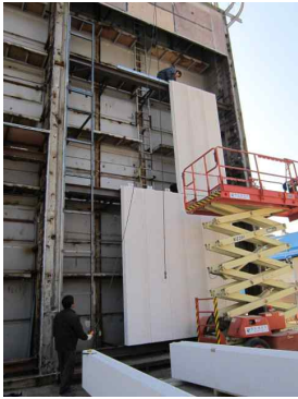
그림 7. ALC 패널 설치
