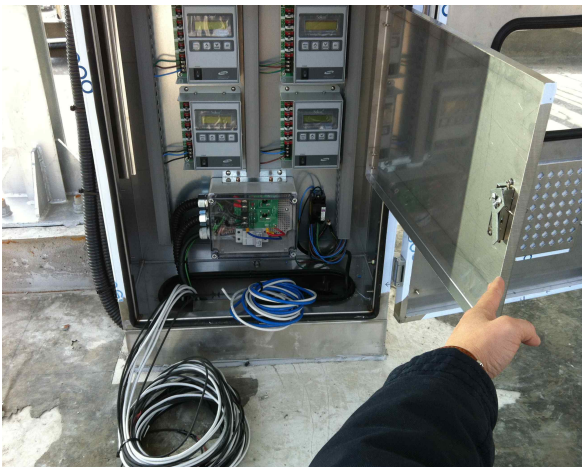
그림 4. 태양광 발전 시스템의 접속반
