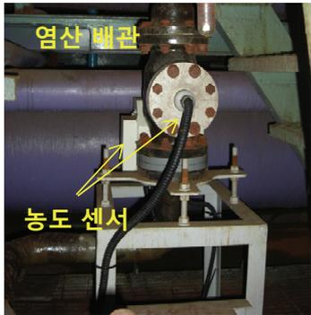
그림 4. 산세라인의 적용된 염산농도 자동 측정 센서.
