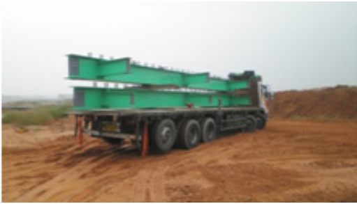
〈그림 6-2〉 하이드로라멘교 거더이동 방법
