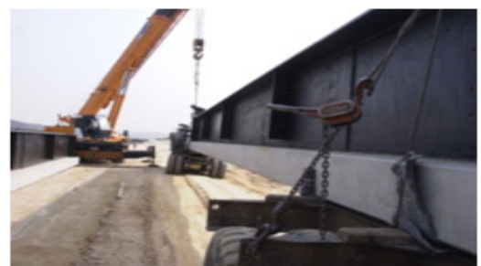
〈그림 6-1〉 기존합성라멘교 거더이동 방법
