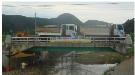
〈그림 13〉 현장재하시험 전경사진
