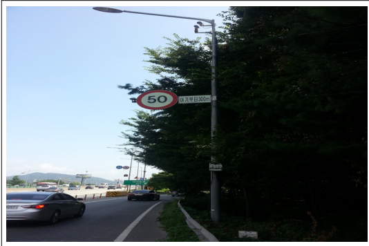
〈그림 10〉 양재IC 현장설치지점 〈Fig. 10〉 Yangjae IC-site installation point
