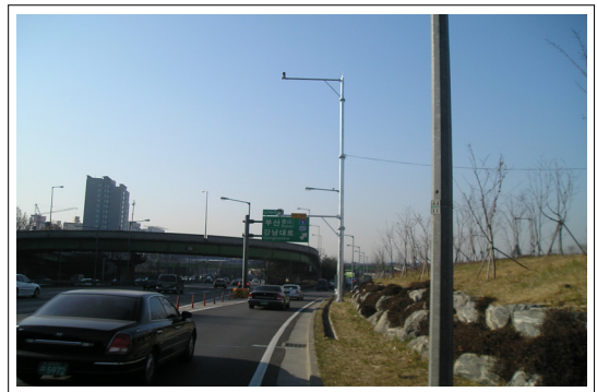
〈그림 9〉 한남대교 현장 설치지점 〈Fig. 9〉 Hannam bridge-site installation point
