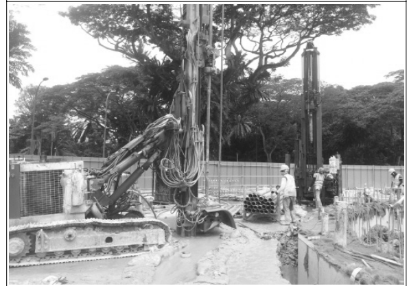
그림 5. Fissure grouting 계획 및 시공전경
