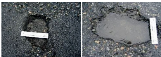
그림 1. 아스팔트 포장의 포트홀 발생 형태
