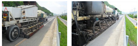
a. 현장가열 재생아스팔트 포장 전경
