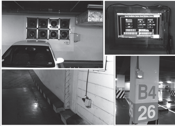
그림 4. 지하주차장 스마트 환기제어 시스템
