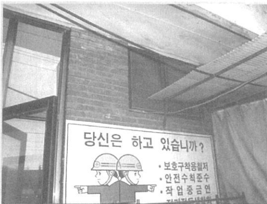
[ 세면장창문: 개방하기가 곤란함]
