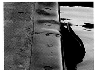
기존 고무모서리보호공 설치-2
