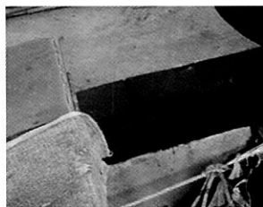
기존 고무모서리보호공 설치-1
