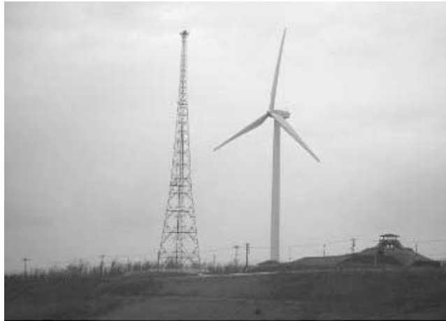
[그림 1] 풍력발전시스템을 낙뢰로부터 보호하는 피뢰철탄
