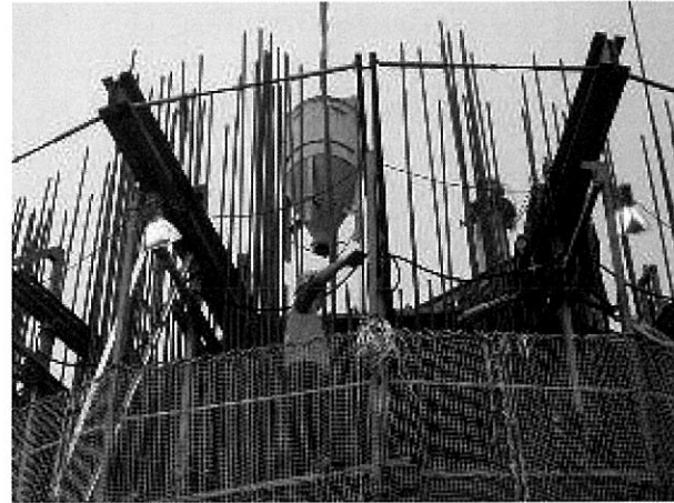
[사진3] 윈치 설치 전 크레인 이용 콘크리트 타설
