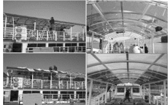
Fig. 14 폴리카보네이트 설치 및 완성
