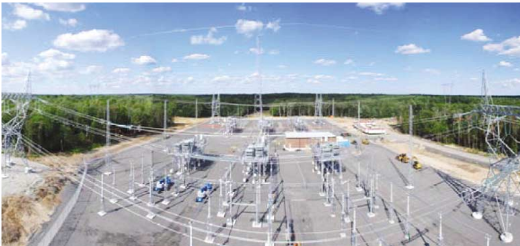
[그림 5] 2개의 Nobel 500 kV 직렬콘덴서의 파노라마 뷰
