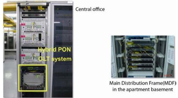
(그림 4) WDM-PON을 이용한 하이브리드 PON 상용 시스템[5]
