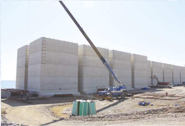
물량장은 육상으로 운반하기 힘든 대형 건설기자재를 해상으로 옮겨 적치하여 놓는 곳으로 블럭을 쌓아 맞추듯이 해안에 조성하게 된다. 약 600개의 블럭이 제작, 완료되어 대기 중이며, 그 중 140개가 물량장에 설치되어 대형 건설기자재를 맞이했다.
