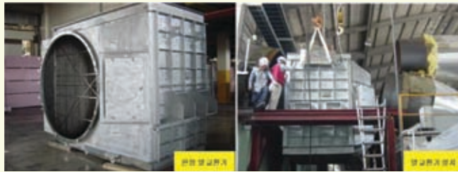
〈그림 7〉 설치된 판형 열교환기와 덕트 연결 과정
