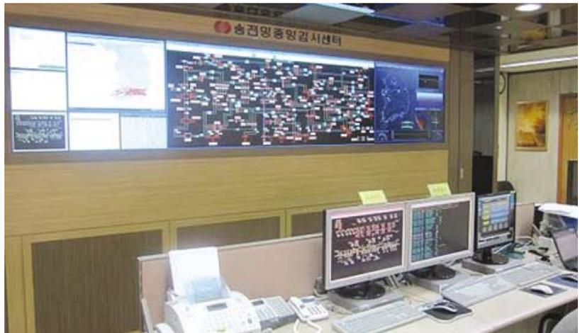
기존에는 외란 발생이나 고장 발생 이후에 수동으로 각 시스템에 저장된 데이터를 수집해야 했기 때문에 사용자가 별도의 노력을 했을뿐만 아니라 데이터 분석 결과도 정확하지 않았다. 그러나 이 시스템은 전력계통의 문제 발생 시 해당 지역의 데이터를 그 즉시 다운로드 해 분석할 수 있도록 사용자 인터페이스를 제공한다.
