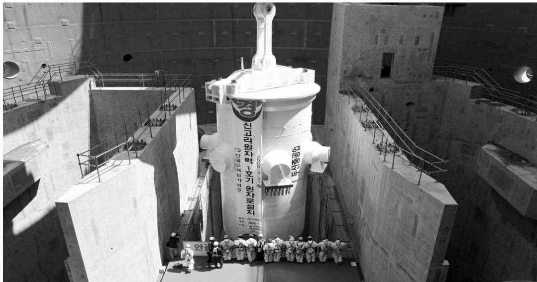
[그림 1] 신고리 1호기 원자로 설치
