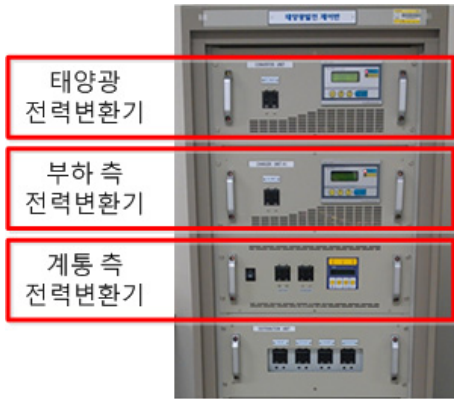
그림 1 태양광-배터리 전원시스템 Fig. 1 PV-Battery Hybrid System Hardware
