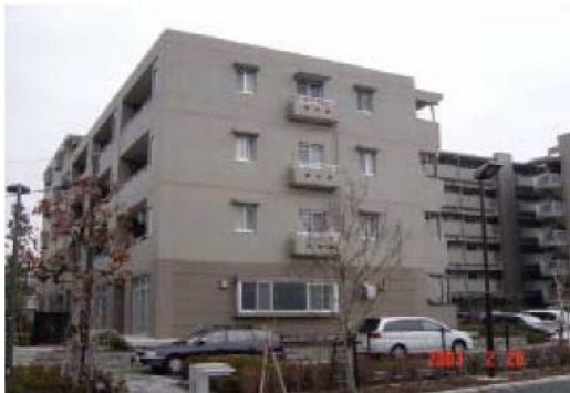
그림 1. 스마트 면진시스템이 설치된 건물
