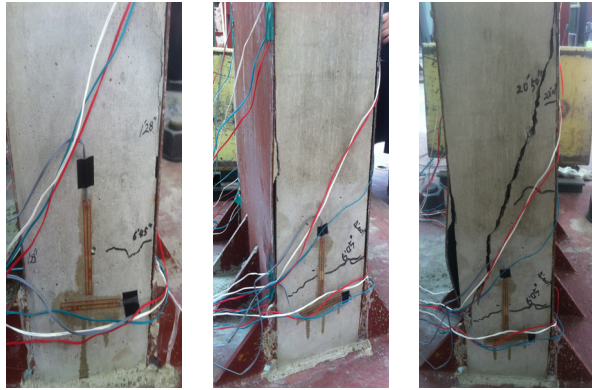
(a) 횡균열 (b) 강판 분리 (c) 전단파괴 <그림 7> 두께방향 하중에 의한 벽체의 파괴 형태
