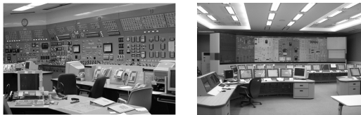
(그림 1) 아날로그 및 디지털 원전 계측제어시스템
