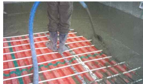
사진 1. 현장 실험 구조 시공 장면
