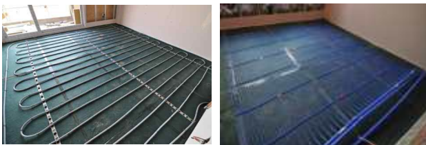
그림 2. PB배관(좌) 및 모세유관(우) 바닥면 설치
