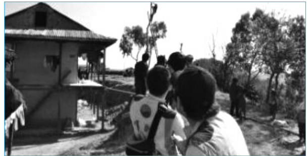
그림 5. 밀림에서 나무를 베어 만든 전신주를 주민들과 함께 세우는 모습(텡간)
