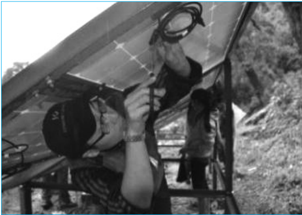
그림 4. 라마 호텔에서의 태양광 발전기 설치 공사
