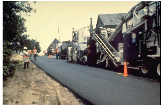
그림 2. 일괄공정 장비 조합을 이용한 현장 상온 아스팔트 재생 공법 과정
