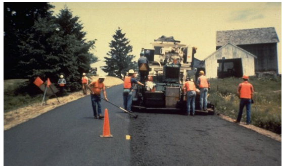
그림 5. 펜실베이니아주 208번 국도에 적용된 현장 아스팔트 재생 공법 시공 현장
